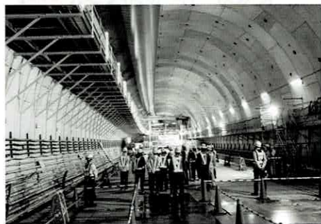
大泉側本線シールドトンネル
